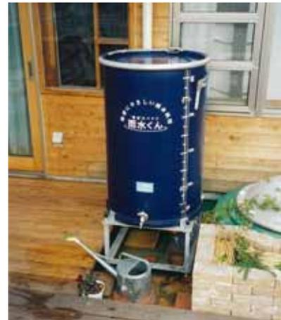
図 - 6 雨水貯留タンク 200 ㍓
